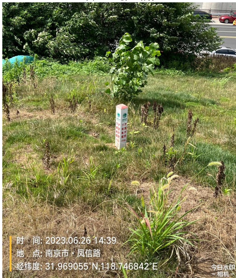
图 6-2 新建地下电缆
