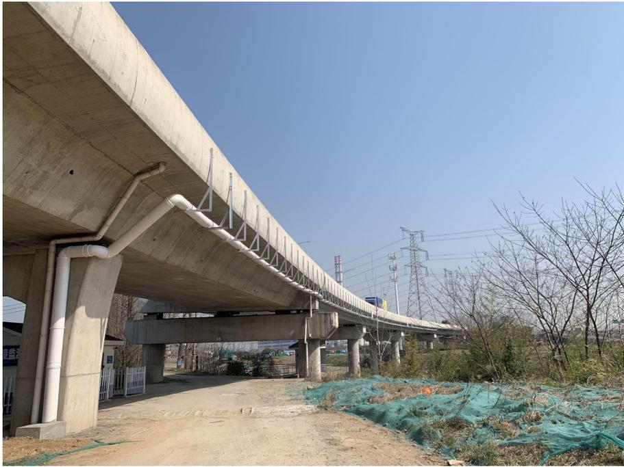
图 5.4-2 项目桥面径流收集系统
