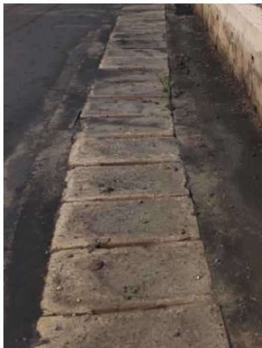
图 8.2-3 散货场盖板沟
