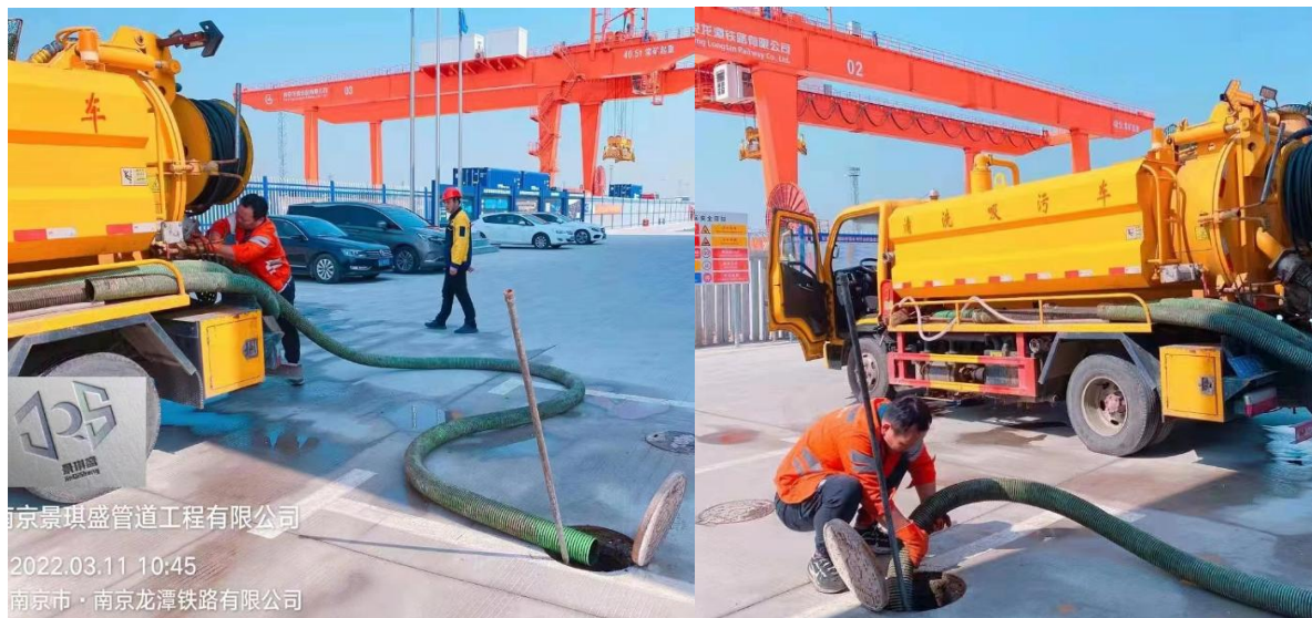
图 8.2-4 集装箱装卸场污水托运
