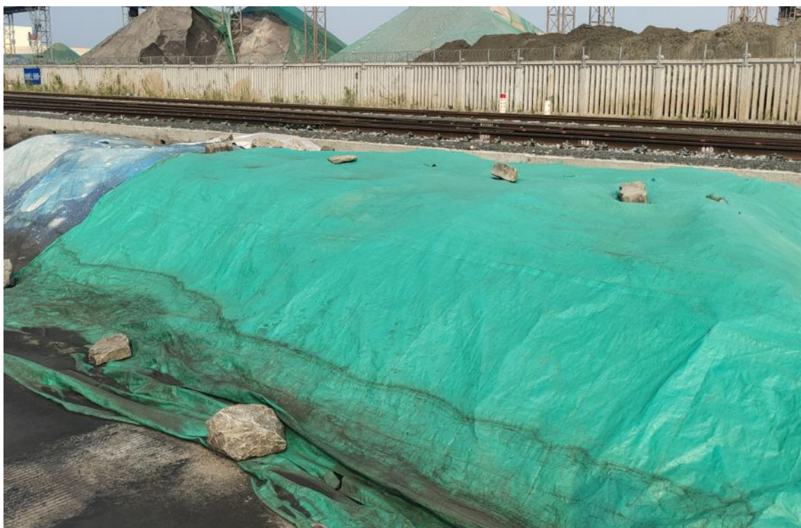
图 9.2-2 散货装卸场临时堆场帆布苫盖
