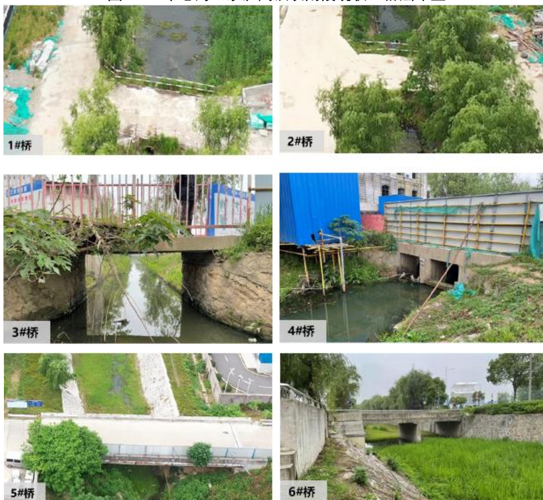
图 3-4 桥涵现状照片
