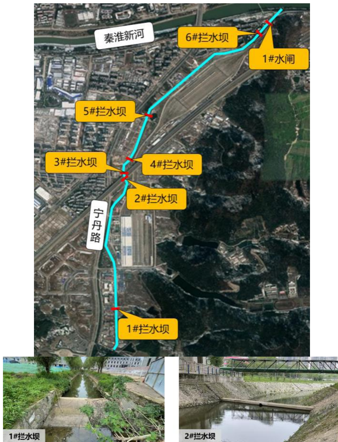
图 3-5 中心河现状拦水坝布置情况及项目区段内拦水坝现状照片
