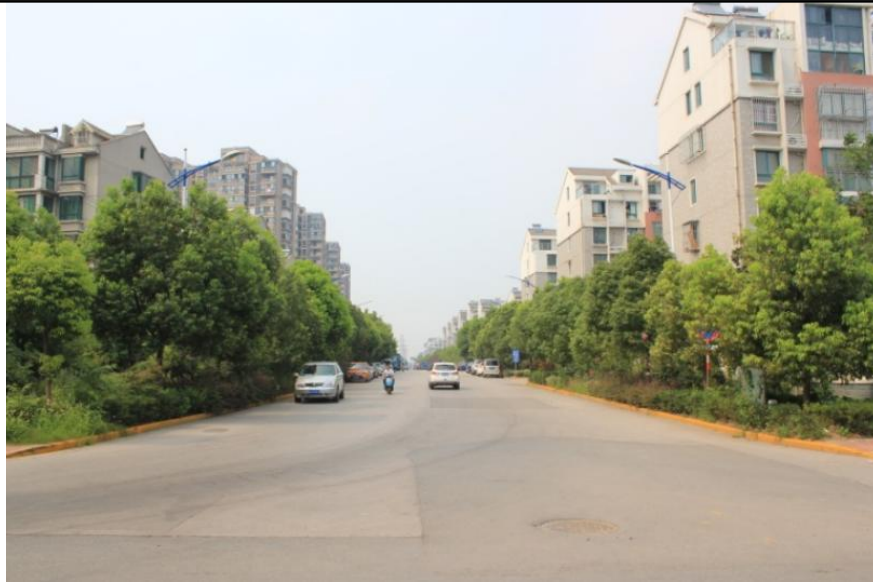
图 3-2 龙淮路老路段现状
